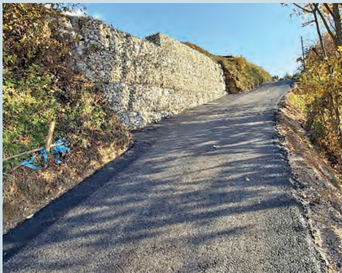
27. 3. ob 17. uri ODPRTJE SANIRANEGA PLAZU IN CESTE ŠPITALIČ–DOLINA Špitalič, pri saniranem plazu
